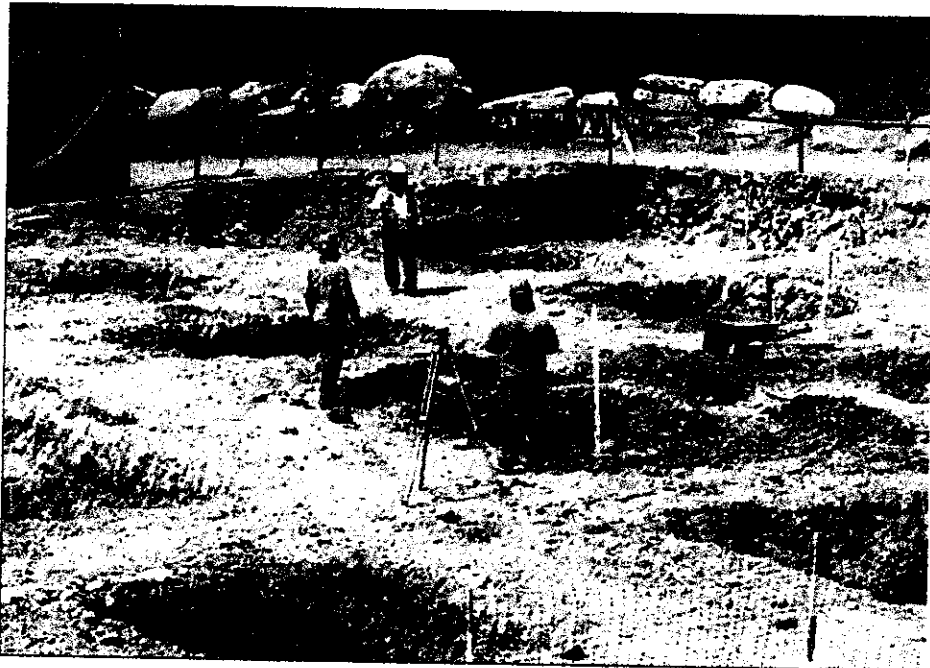
Trazo Y Replanteo Para Excavación De Zapatas.
